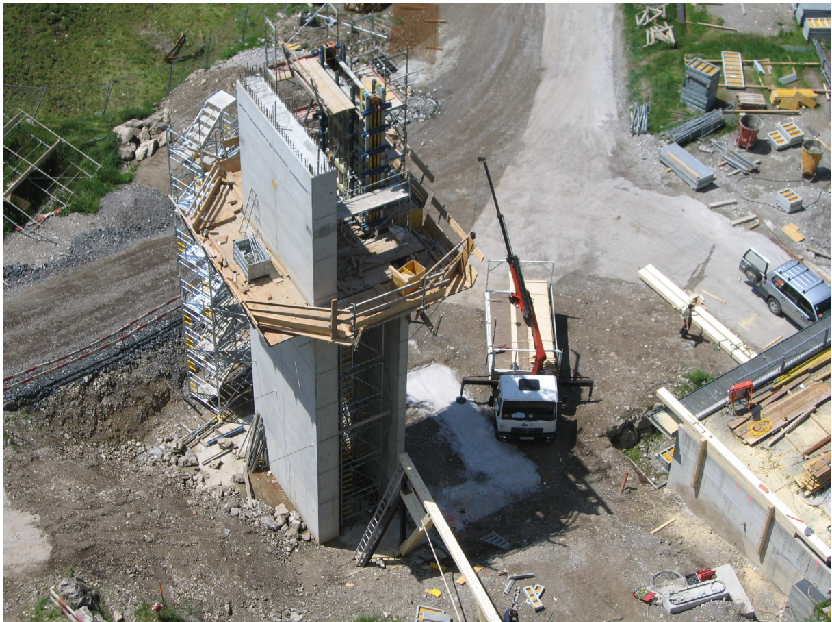
Hauptstütze + Aufzugschachtwand
