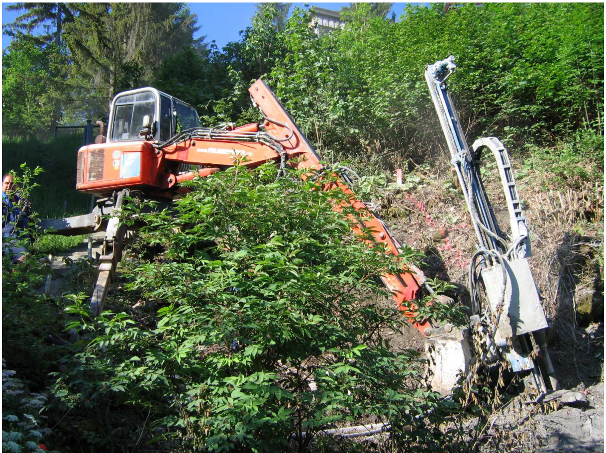
Bohren von Micropfählen zur Gründung des neuen Trainerpodestes
