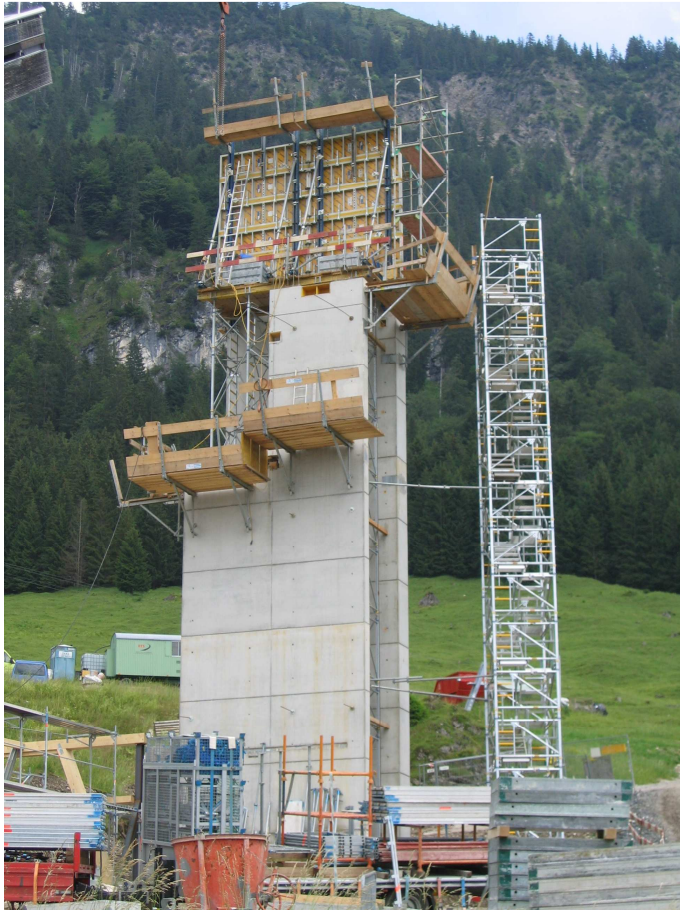
Hauptstütze + Aufzugschachtwand
