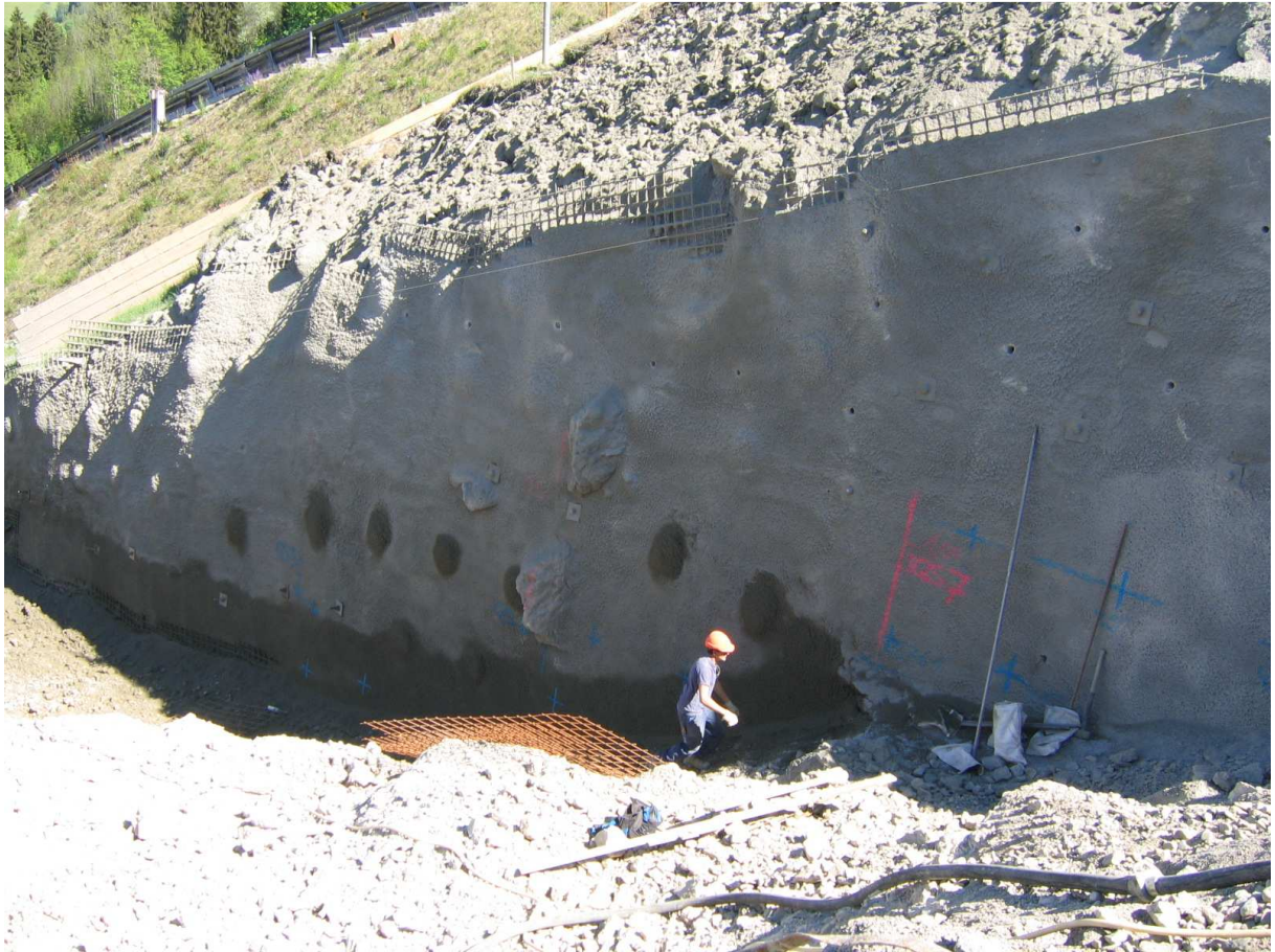
Bohren von Micropfählen zur Gründung des neuen Trainerpodestes
