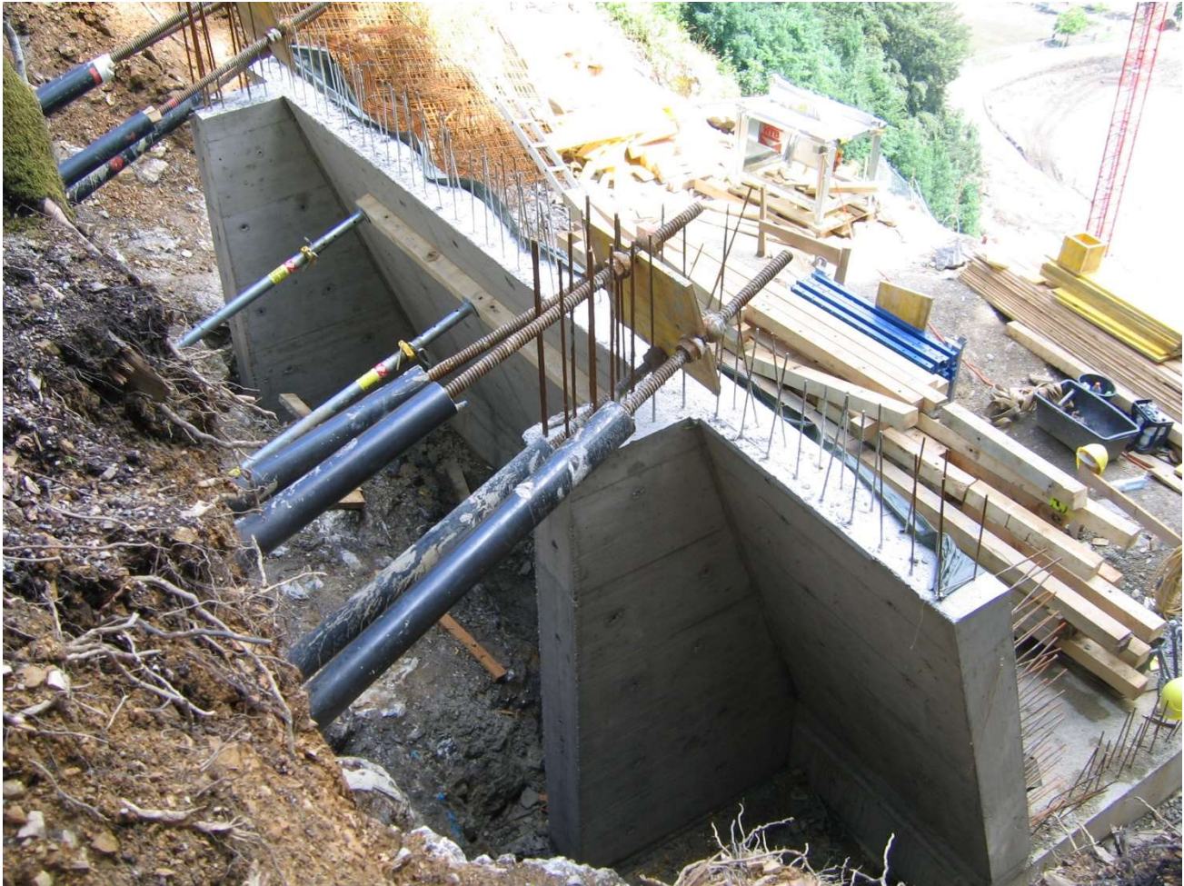
Juli 2016: Mikropfähle Stützenfundament
