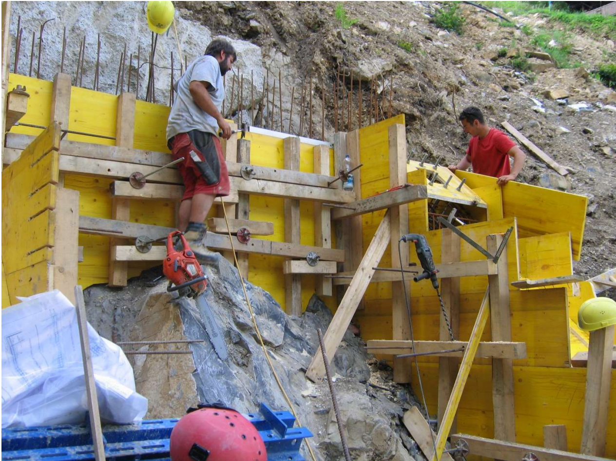
August 2016: Schalung Stützenfundament
