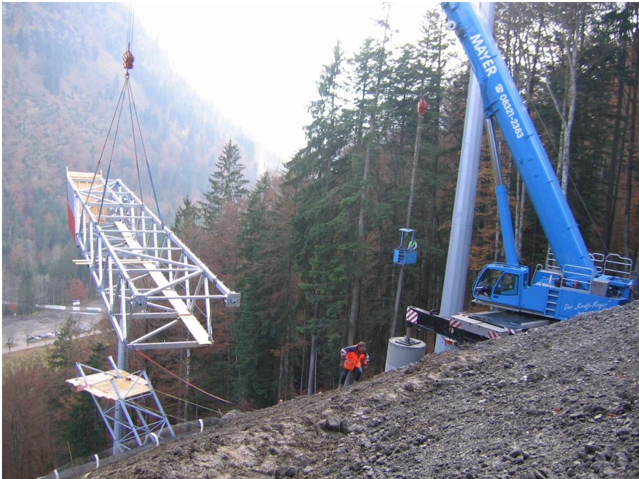
November 2016: Einheben Fachwerkbrücke
