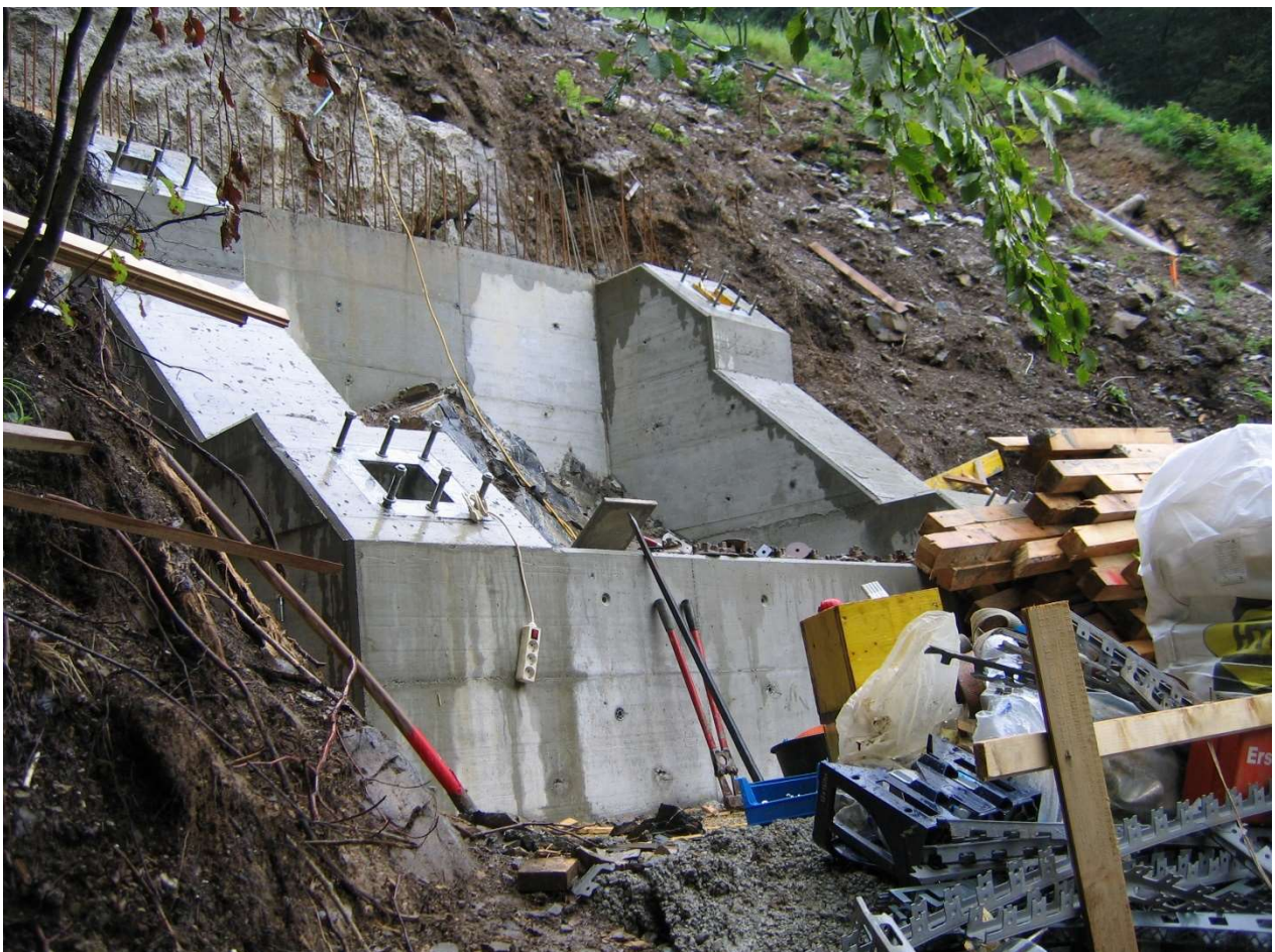
August 2016: Stützenfundament
