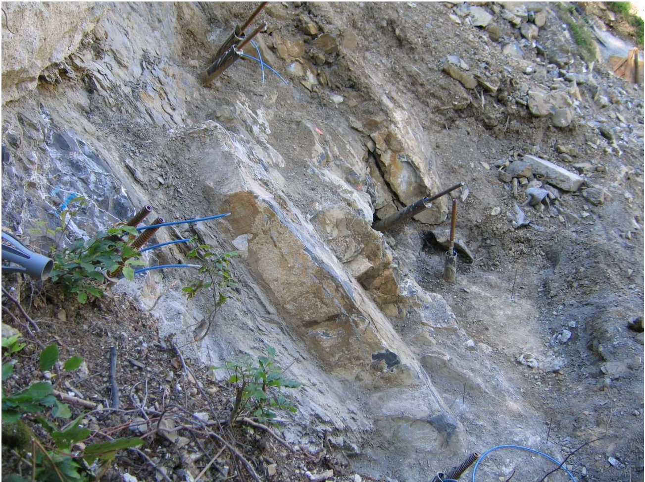
Juli 2016: Mikropfähle Stützenfundament
